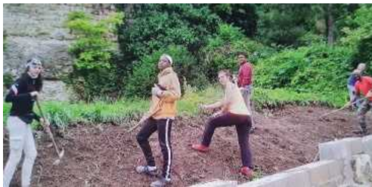
Les jeunes de l'association Le chemin travaillent sur les chantiers de restauration de la Maison de Talleyrand-Périgord. THIERRY DUBRUNFAUT
